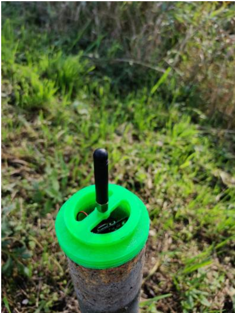
Fig. 8: Sensor und LoRa-Sender im Rohr installiert
